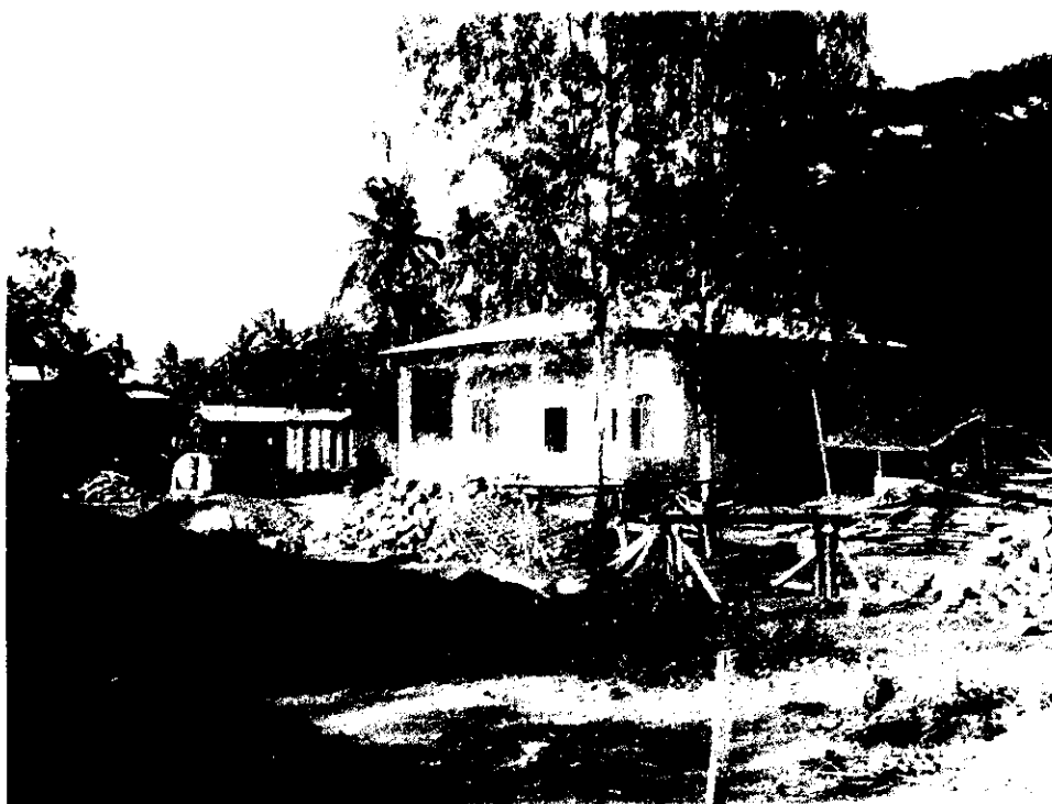
技術訓練学校の電気工事コースの校舎
