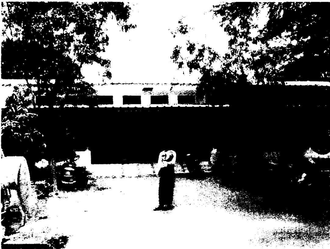
草の根無償資金協力で建設したメッティーラの病院内の小児病棟
