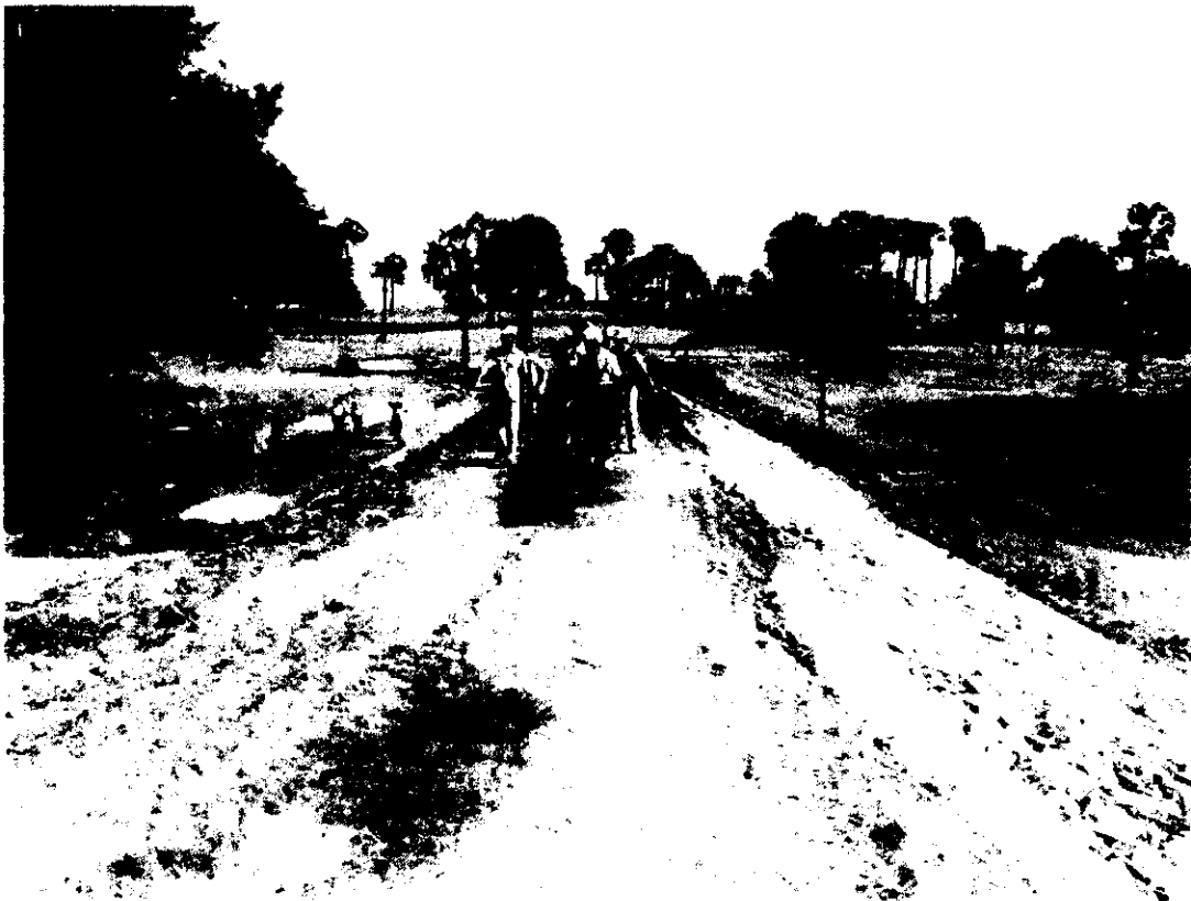
住民が主体になり建設中のダム
