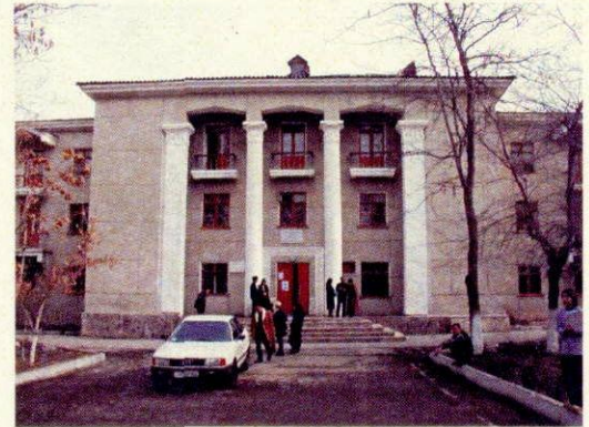
7号館入口(センターの看板あり)
