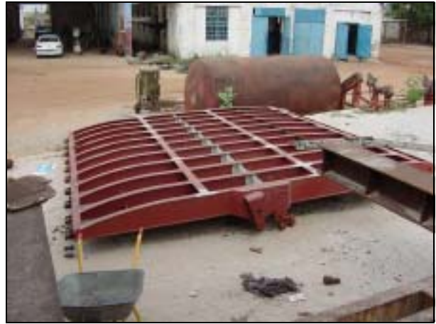
写真 20 損傷したランプドアは鋼材溶接、下塗りにより修理
