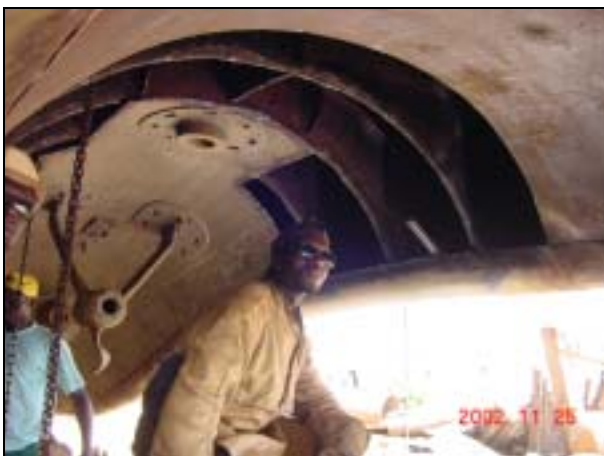
写真 17 シャフトトンネル外板部発錆箇所の取替えの様子
