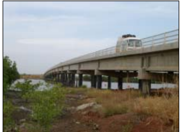
写真 52 ガンビア川支流に建設されたケラフーンの橋梁
