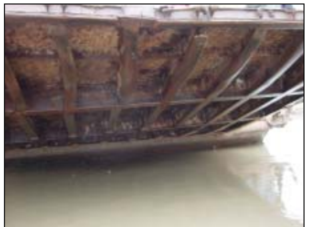
写真 6 船首部、船尾部のランプドア裏側は溶接部の割れ、補強材の変形、発錆が著しい
