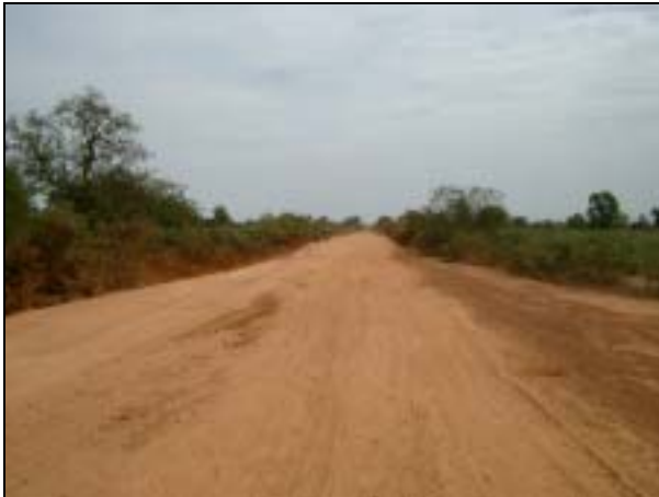
写真 51 ガンビア国のケラフーンファラフェニ間のラテライト土の未舗装道路
