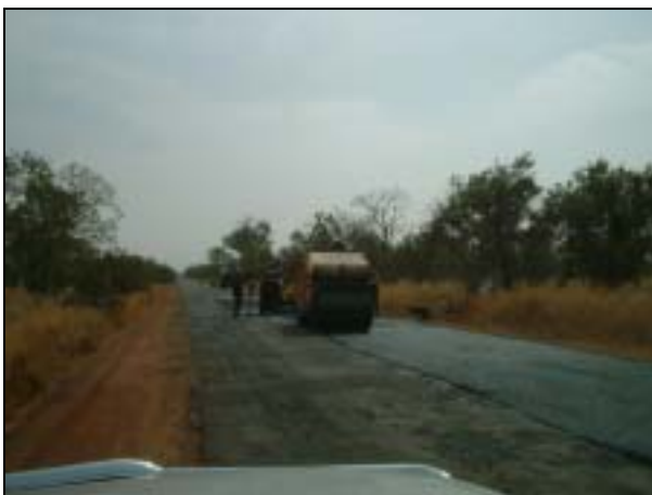
写真 53 セネガル国では定期的に国道のメンテナンスが実施され、舗装状況は良好である
