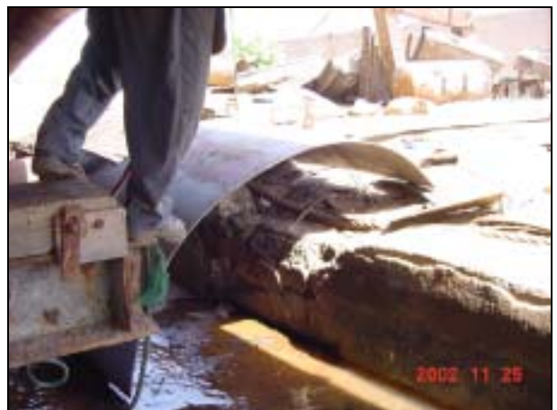
写真 18 シャフトトンネル外板部の交換材曲げ加工の様子
