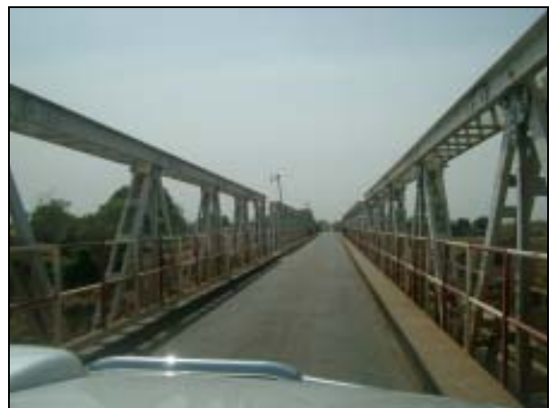
写真 54 セネガル車輛がトランスガンビアを通過しない場合、迂回路となるタンバクンダの橋梁
