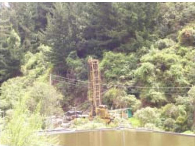
Pozo perforado en Vitelma para el proyecto piloto de recarga del Estudio. Este pozo comprobó la alta capacidad de recarga artificial de la formación Guadalupe en ese punto (900m<sup>3</sup>/day).
