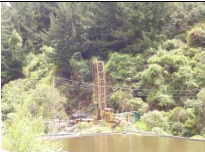
Vitelma 取水地における人工涵養パイロットスタディのための井戸掘削状況。この井戸はグアダルペ層の高い人工涵養能力を示した（900m<sup>3</sup>/日）。
