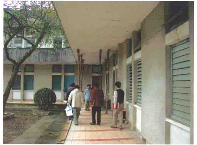
既存放射線部への通路
