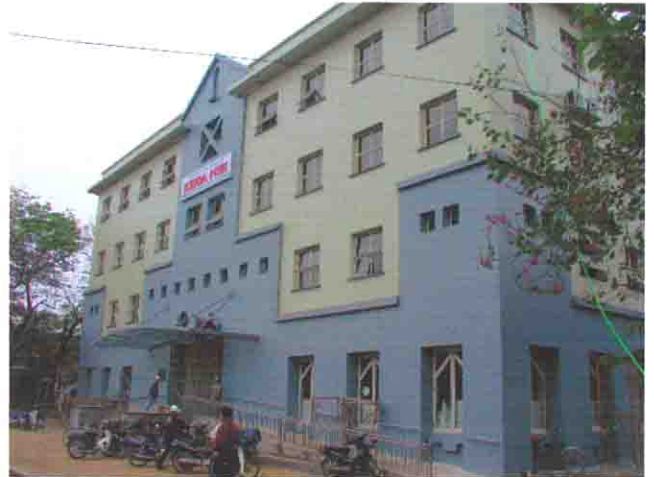
小児棟（EMW支援、建設中）
