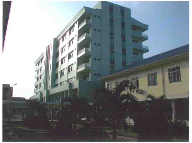
内科・外科病棟
