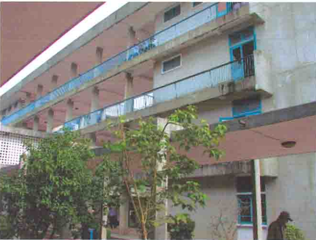
内科・外科棟
