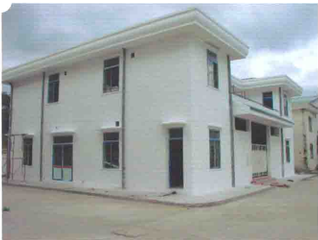
死体安置所（新設）
