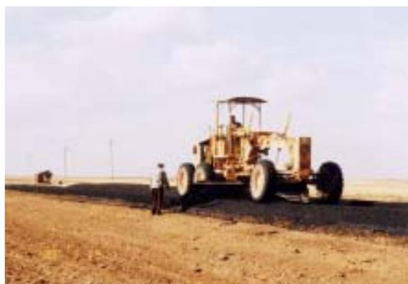
ERA が実施中の常温アスファルトによる舗装補修工事
