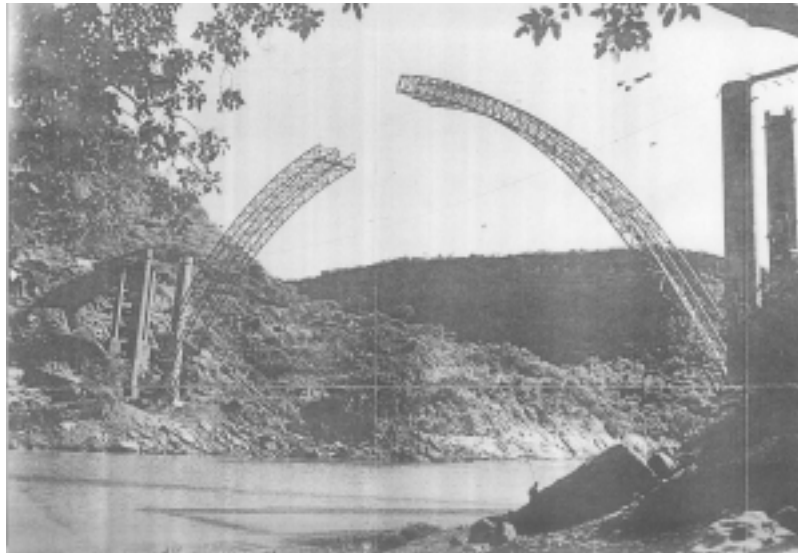
図 - 13 アバイ橋建設時の写真
