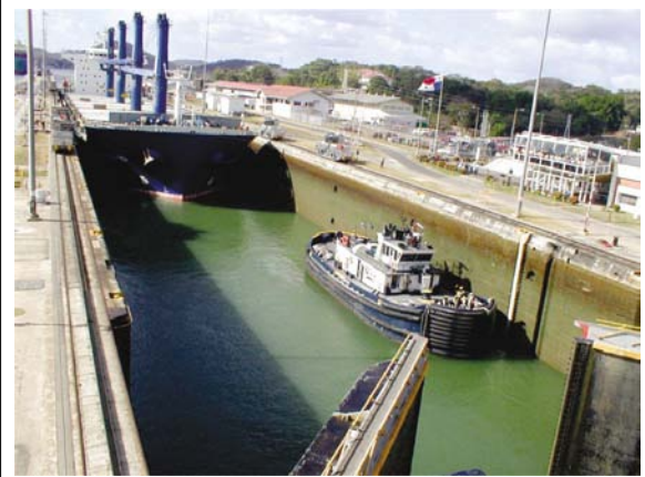
パナマ運河ミラフローレス閘門
