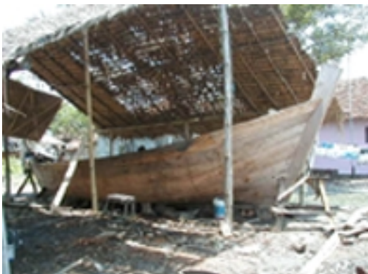
漁船の建造現場
