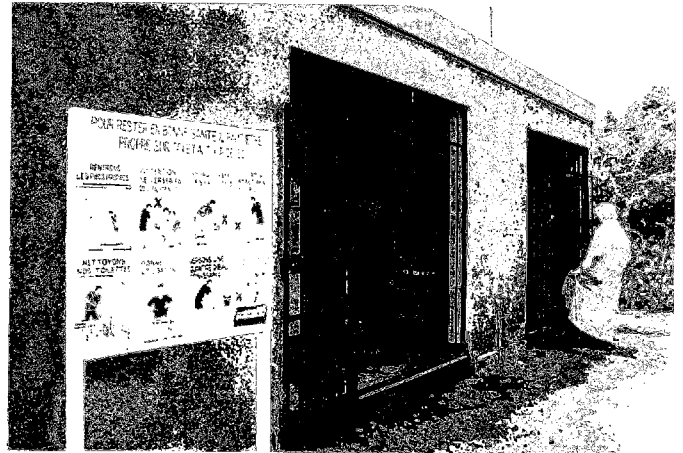
8 水洗トイレ（ニアメ市内 バンダバリ小学校）
