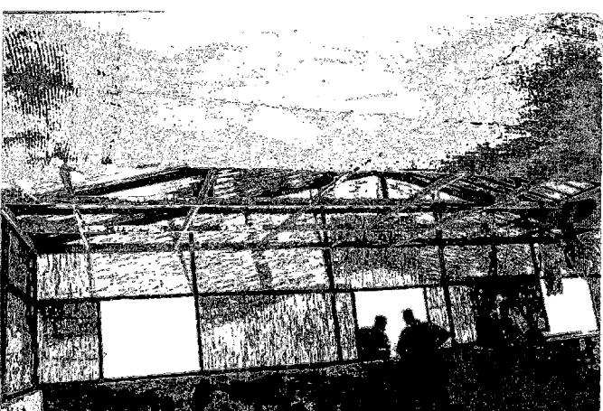
6 壁がないため、風通しがよく涼しい。 天井には熱よけのゴザ（住民参加型の教室）
