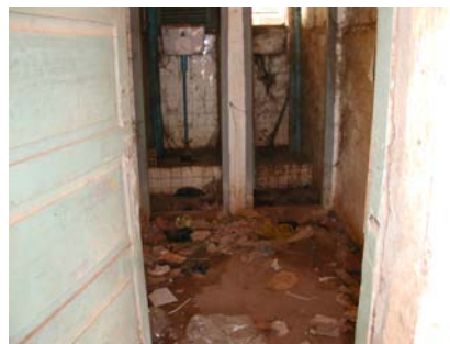
教室棟トイレ
