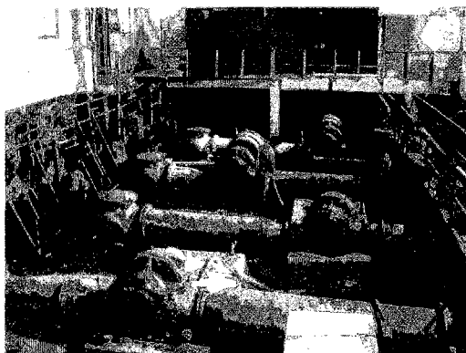
配水ポンプ場 2000\text{m}^3 \times 2 の配水池がある。 Q=1800\text{m}^3/\text{h} 、 H=30\text{m} 、 315\text{kW} \times 5 台 Q=350\text{m}^3/\text{h} 、 H=30\text{m} 、 75\text{kW} \times 1 台
