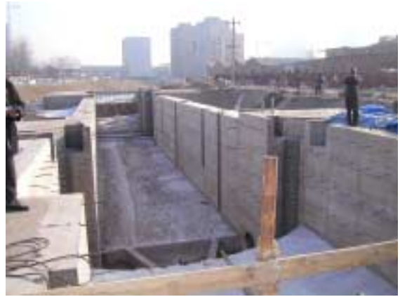
閘門設備工事
