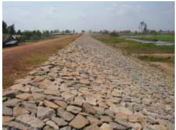
輪中堤の一部は波浪から堤体を護るた めリップラップで補強されている。
