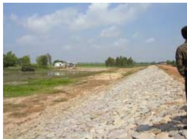
輪中堤 (写真右側の堤外地の住民は 洪水時には居住地区に避難する)
