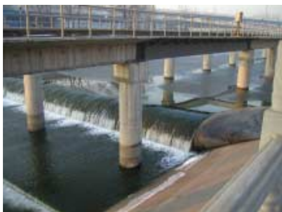
南環水路の基点にあるラバーダム 上流側に放水路があり、この堰のラバーダムによって、市内に洪水が流れ込むのを防ぐ。
