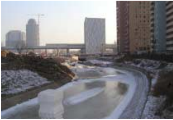
北京市北環水路改修工事
