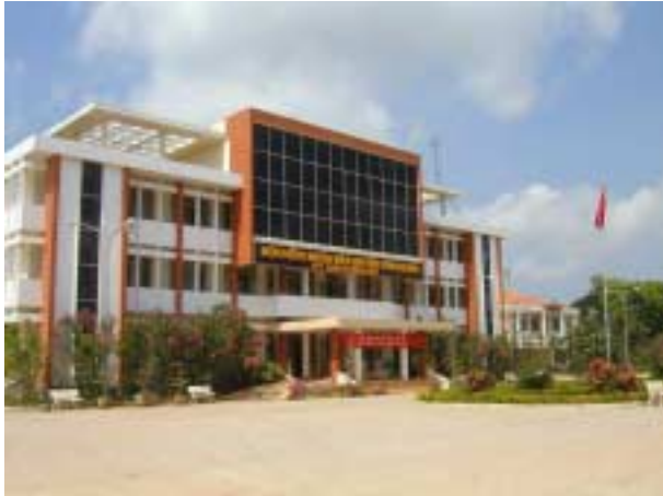
Vinh Hung 住居地区内にある 同地区委員会建物
