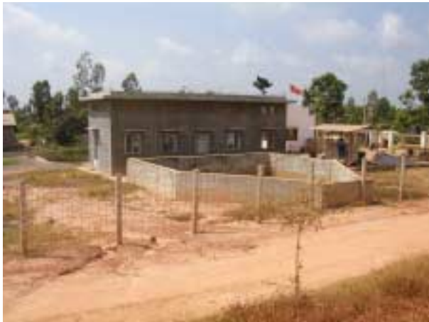
内水排除のためのポンプ場 が設置されている。
