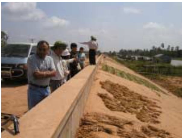
水路沿いの堤防は、波浪対策のため コンクリートで保護されている。
