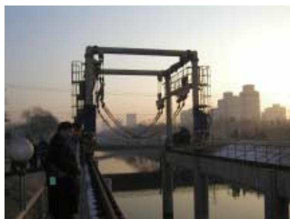
南環水路の基点にある遊覧船移動機 遊覧船が、堰を越えて、市内の環水路に移動させるための移動機。
