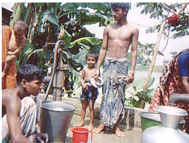
図 1-4 DSK によるスラムにおける給水施設設置のその利用
