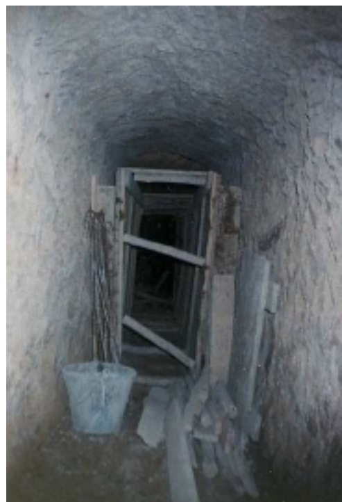
写真2-6 改修中のハッターラ内部
