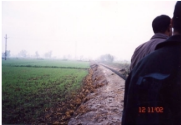
◀世界銀行/ドイツプロジェクトによる実施地区（レイズドタイプメスカ：盛土され水路が設けられている）
