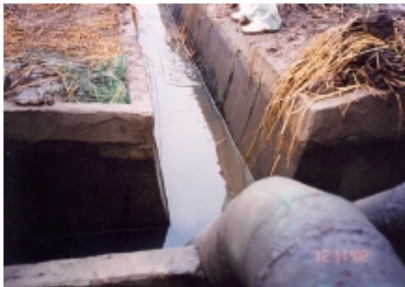
◀世界銀行/ドイツプロジェクトによる実施地区（レイズドタイプメスカ：手前に設置されたポンプにより揚水される）
