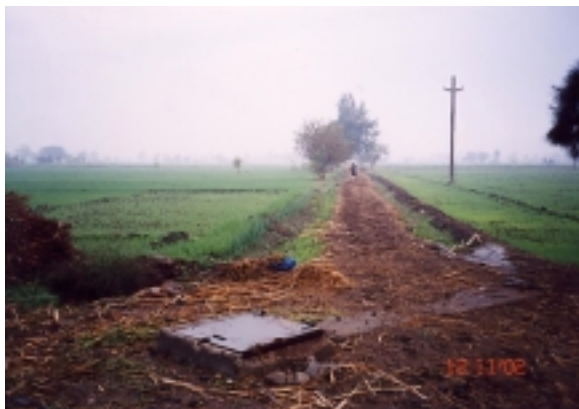
◀世界銀行/ドイツプロジェクトによる実施地区（耕作道の下にパイプラインが埋設されている）
