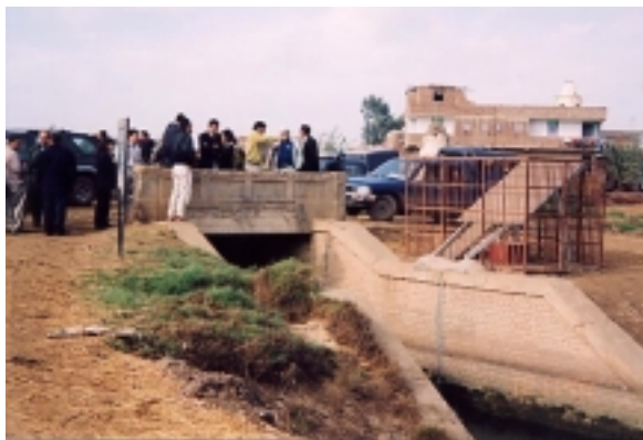
◀ デリバリーキャナル取水口 (流量を観測するための計器が設置されている)
