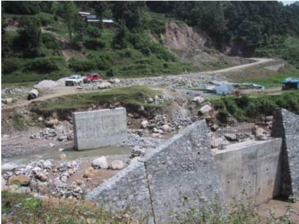
オカルポワ最終処分場アクセス道路の橋建設
