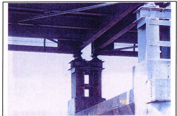
完成写真には支承台座の横梁はない。遠望の写真しかないが、完成直後にはトラス部材の歪み、変形は確認できない。
