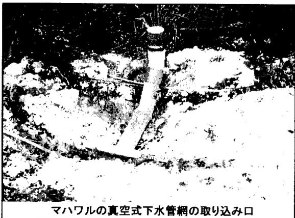
マハワルの真空式下水管網の取り込み口
