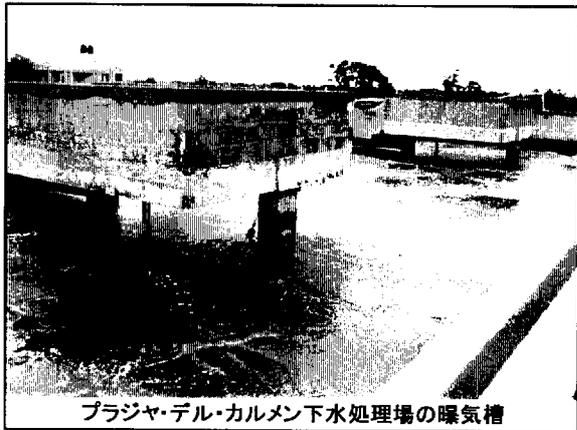
プラジャ・デル・カルメン下水処理場の曝気槽
