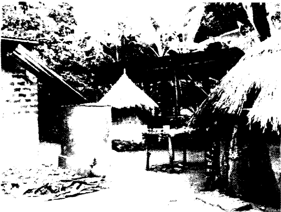
先進的農家の敷地内。屋根から雨水を集め、貯水するタンクがある。また、後方には伝統的な円筒形穀物倉、更に後方には乾燥穀物倉が見える。
