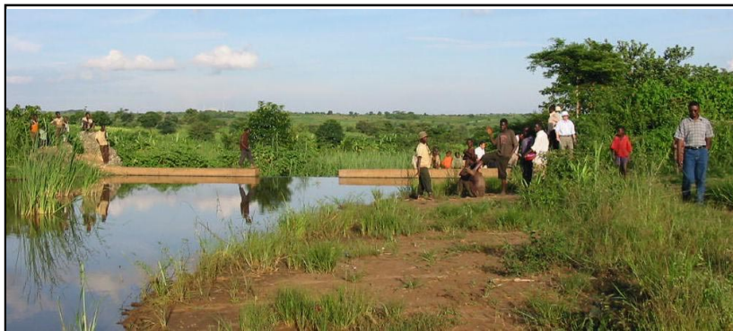
CARE Malawi : Khongo Dam( Lilongwe 郊外 ) 村落に灌漑用の堰を造り、農業や生活用水に使い、流れをせき止めてできた貯水池に魚を放養するプロジェクト
