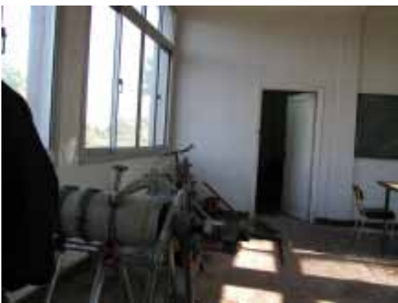
写真 19 : Damanhur 市、NOPWASD 訓練センター 配管修理実習室
