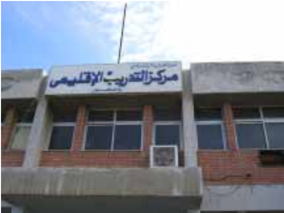
写真 18 : Damanhur 市 : NOPWASD の訓練センター
