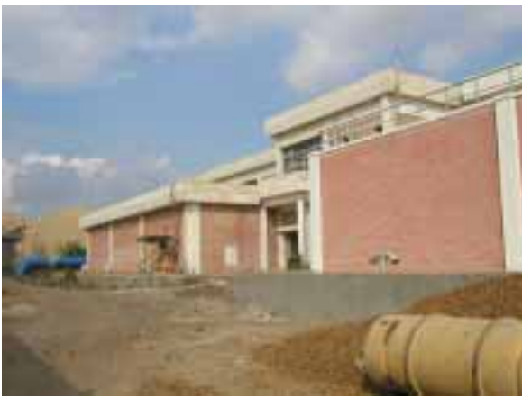
写真 8 : Abbasa 浄水場（ろ過池、増設分）
