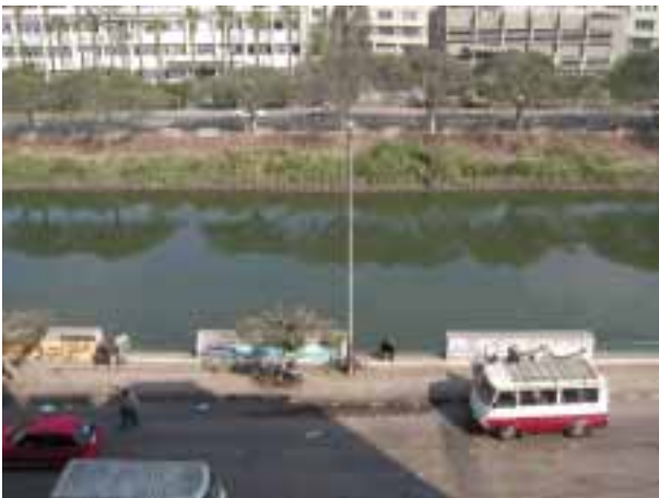
写真 2 : Muweis Canal ZAGAZIG 市内
