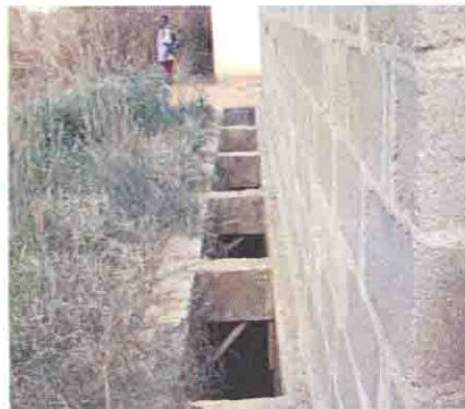
便所の汚水槽
