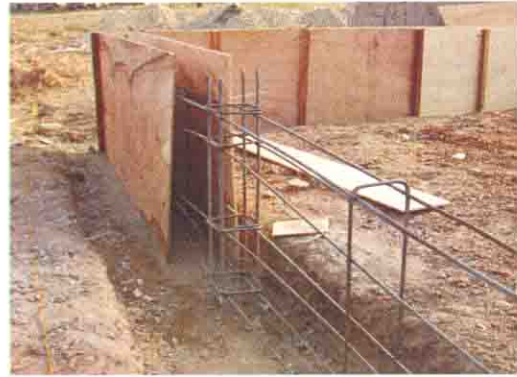
基礎立上り部分の配筋
