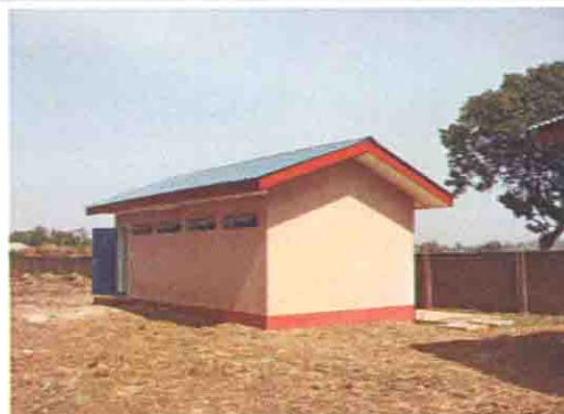
新設便所 (6ブース)
