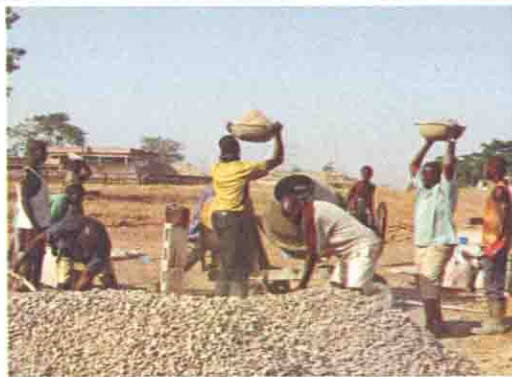
ミキサーによるコンクリート練り
