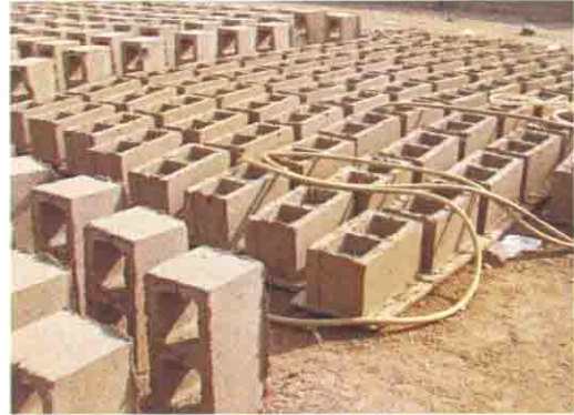
養生中のサンドクリートブロック
