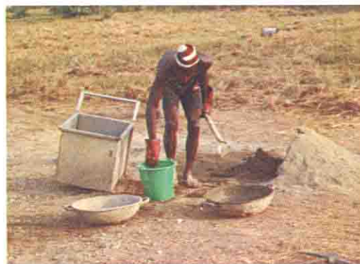
モルタルをつくる作業
