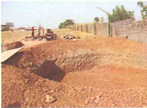
建設場所 (鉄塔用基礎の根切りが完了の状態)
