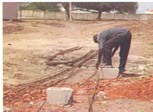
鉄筋の加工作業（鉄筋は曲げられた状態で現場に搬入）
