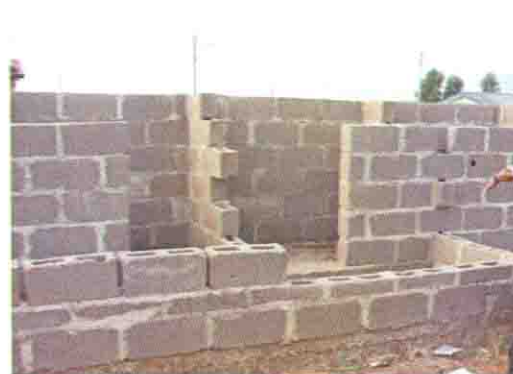
工事中の便所
