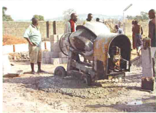
練り上がったコンクリート
