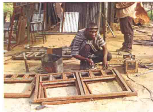
溶接組立作業 (かなり錆がでている材料を使用)
