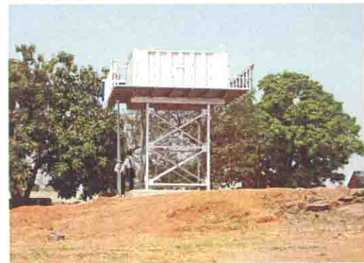
新設高架水槽
