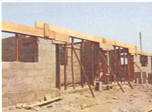
梁の木製型枠
