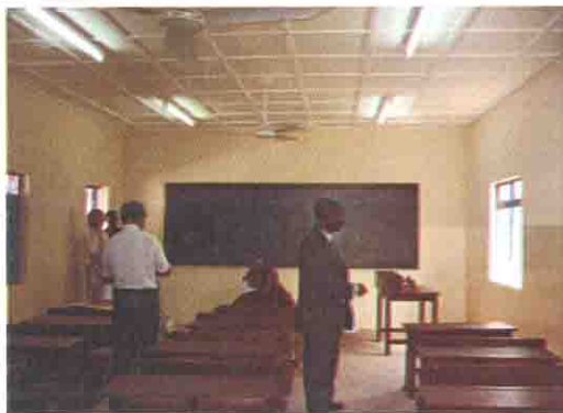
教室内部 (天井照明器具、天井扇有り)
