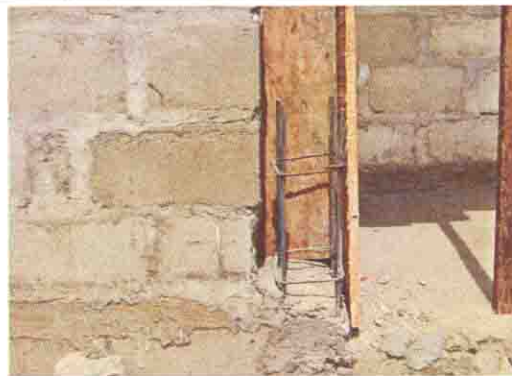
コンクリート柱の配筋と型枠
