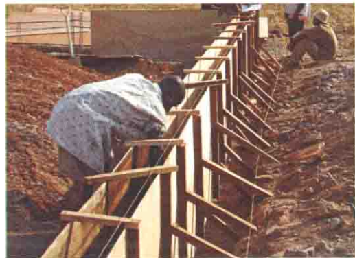
基礎立上り部分の合板型枠
