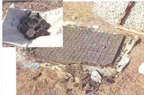
床配筋用スペーサーの製作
