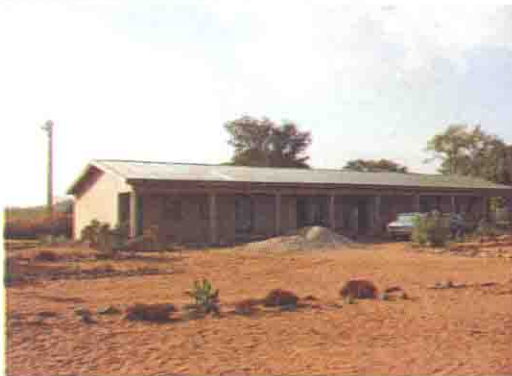
工事中の校舎全景
