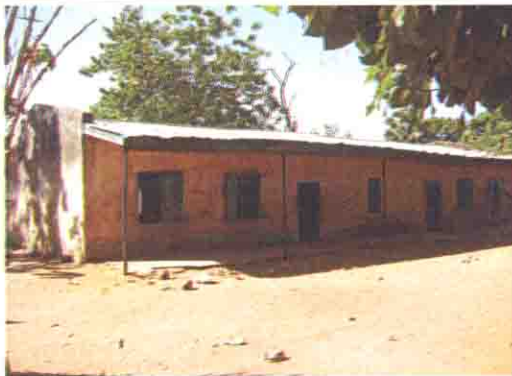
既存校舎の全景
