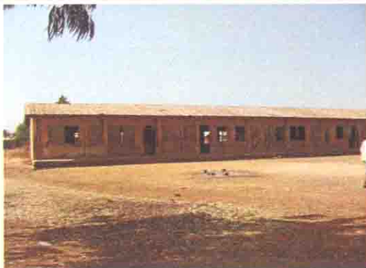
既存校舎の全景
