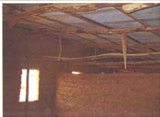
壁間仕切りで2分割された教室内部
