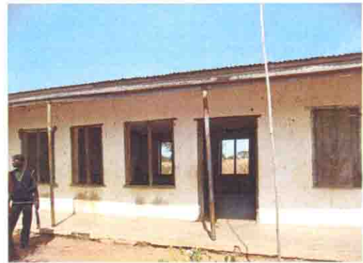
ドアや窓がない状態の教室
