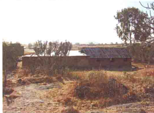
既存校舎背面の全景
