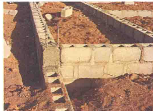
ブロック積みの基礎立上り部分
