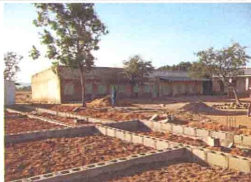
既存校舎の全景 (手前はUBEによる学校建設中の現場)
