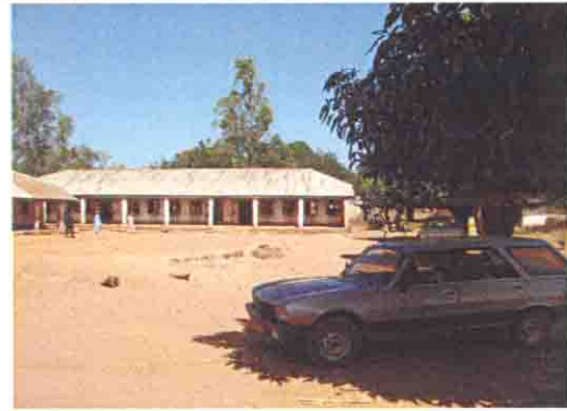
既存校舎の全景
