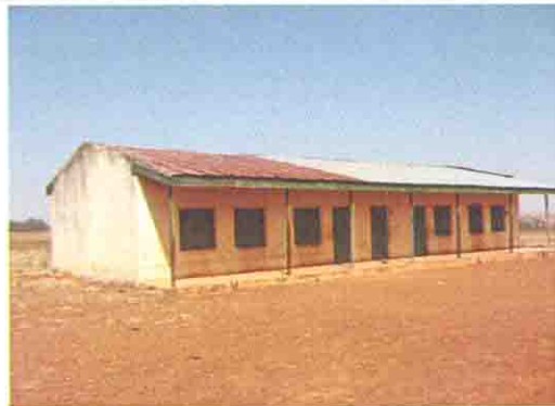
既存校舎の全景
