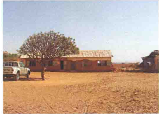
既存校舎の全景
