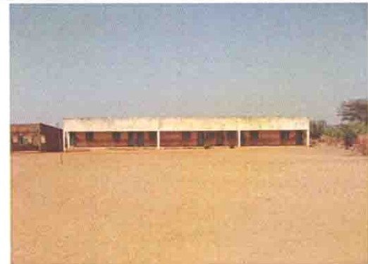
既存校舎の全景
