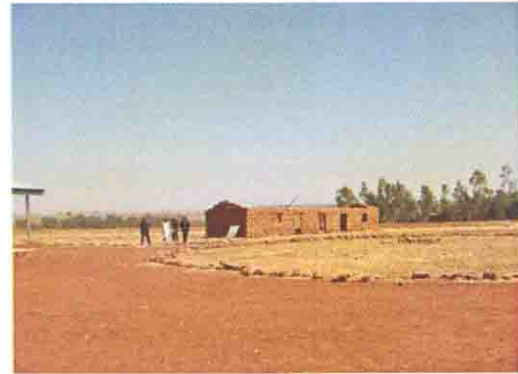
工事途中の校舎
