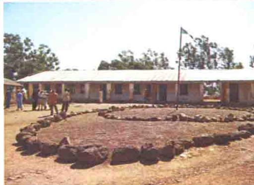
既存校舎の全景
