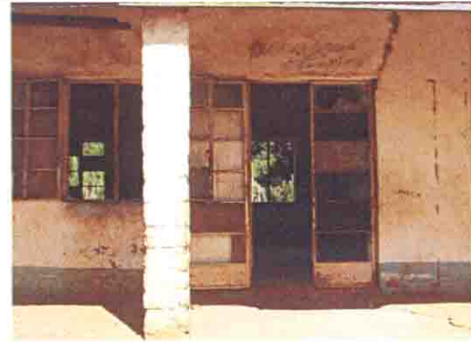
教室の窓とドア（1970頃建設の校舎）
