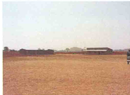
コミュニティによる校舎（左側建物、工事途中で中止）
