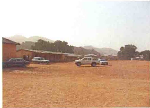
既存校舎の全景
