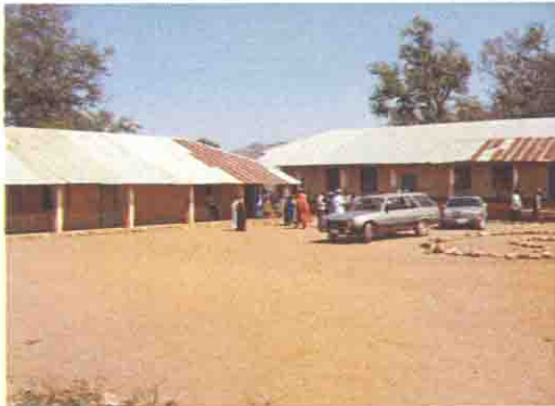
既存校舎の全景
