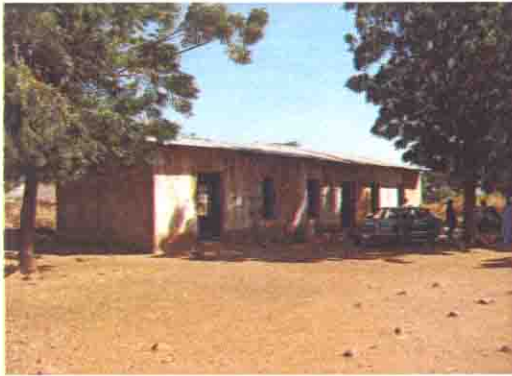
既存校舎の全景
