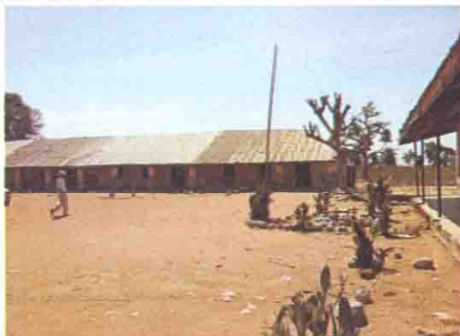
既存校舎の全景
