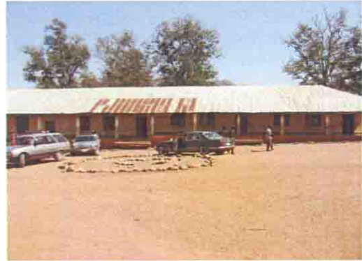
既存校舎の全景
