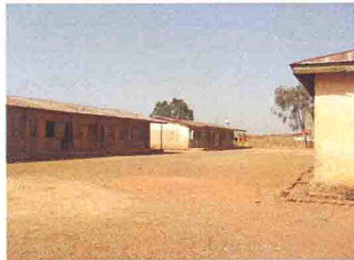
既存校舎の全景
