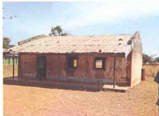
既存校舎の全景
