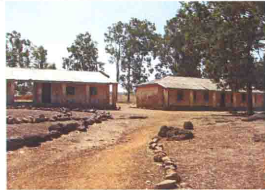
既存校舎の全景
