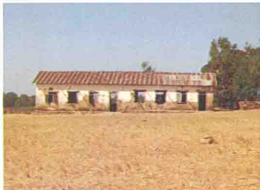
既存校舎の全景
