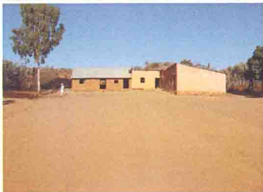
既存校舎の全景
