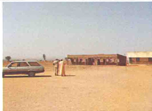
既存校舎の全景
