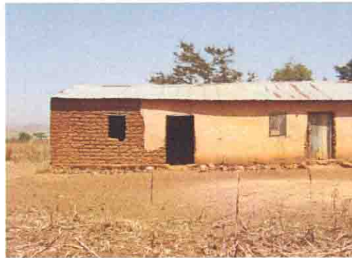
コミュニティにより建設された校舎
