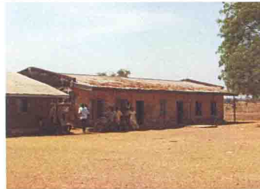
既存校舎の全景
