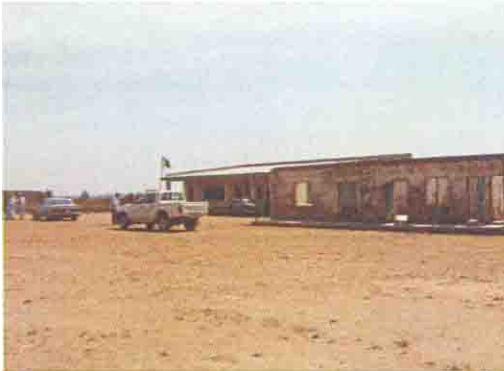
既存校舎の全景
