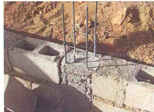
外廊下の柱鉄筋の立上げ部分
