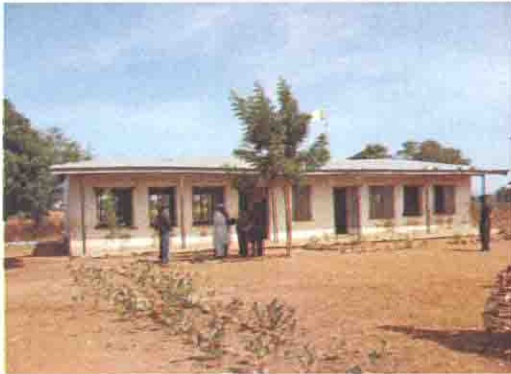
既存校舎の全景
