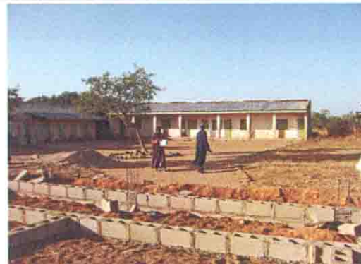
既存校舎の全景
