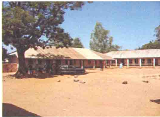
既存校舎の全景
