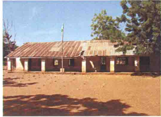
既存校舎の全景
