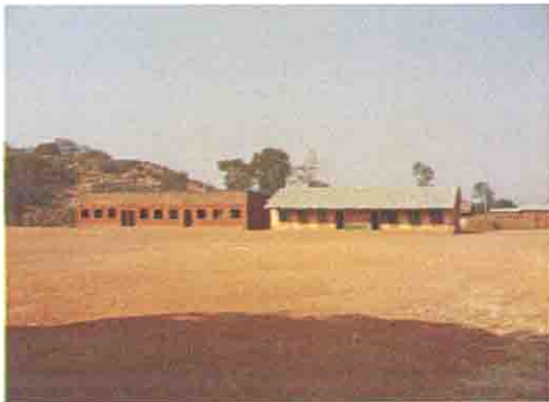
既存校舎 (左側がレンガブロック積み校舎)
