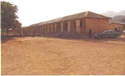
既存校舎の全景
