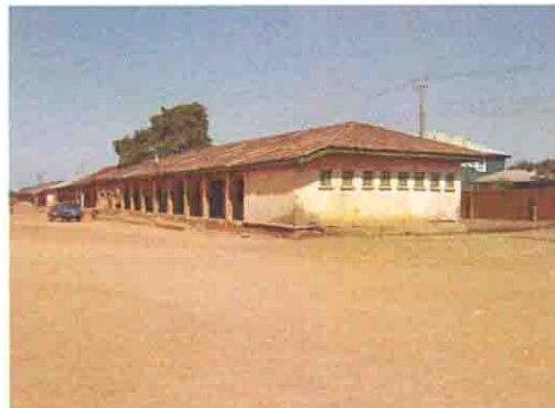
既存校舎の全景
