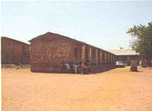
既存校舎の全景 (1946年建設、1996年改修)
