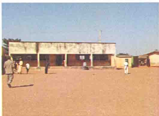
既存校舎の全景
