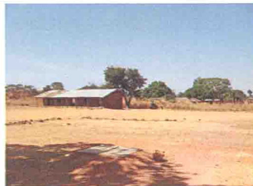
コミュニティにより建設中の校舎
