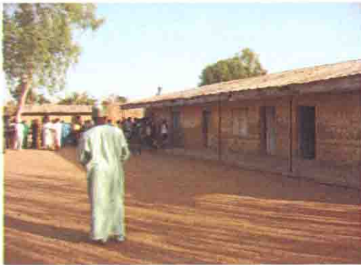
既存校舎の全景
