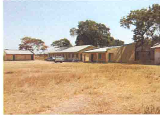
既存校舎の全景
