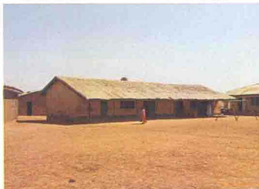
既存校舎の全景 (一部幼稚園に使用)
