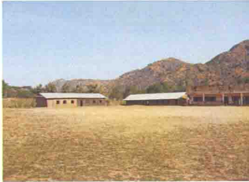
既存校舎の全景
