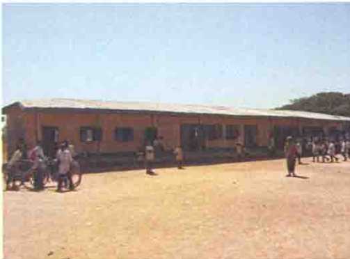
既存校舎の全景
