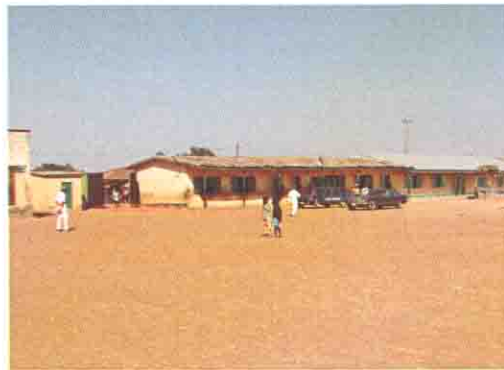
既存校舎の全景
