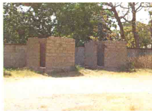
工事が中断されたトイレの建設現場
