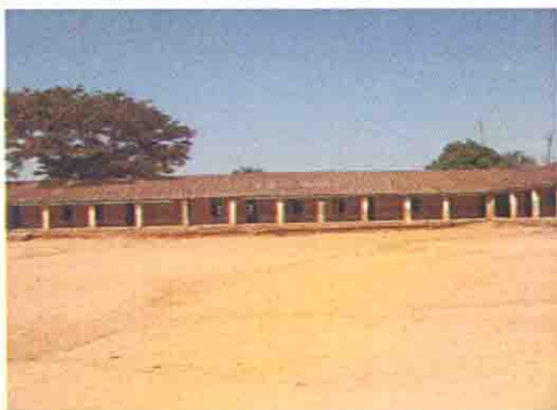
既存校舎の全景 (Kaduna市街地内)
