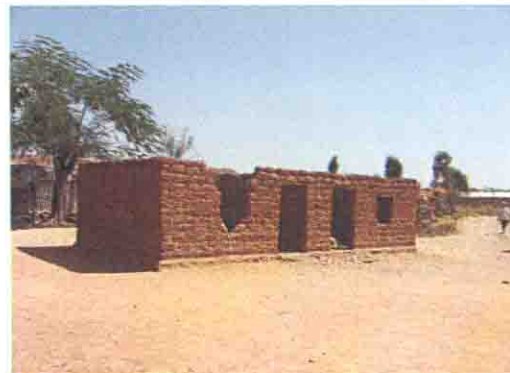
コミュニティにより建設中の校舎
