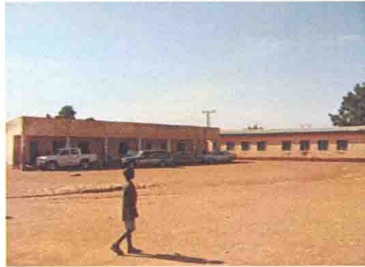
既存校舎の全景
