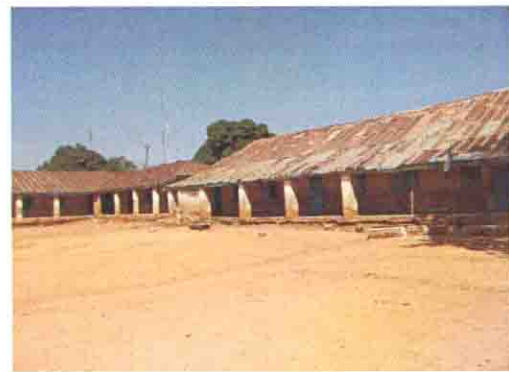
既存校舎の全景
