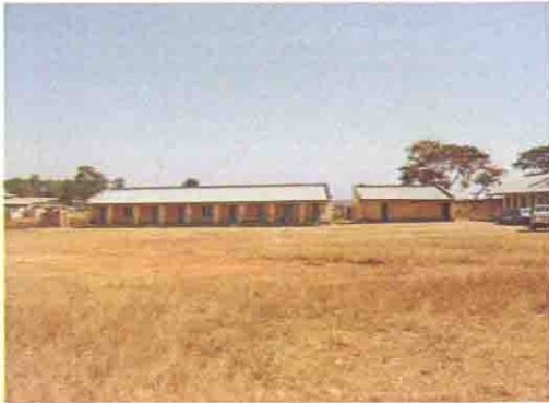
既存校舎の全景
