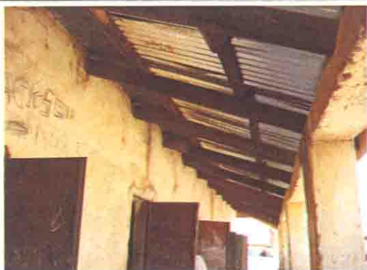
既存校舎の外廊下部分
