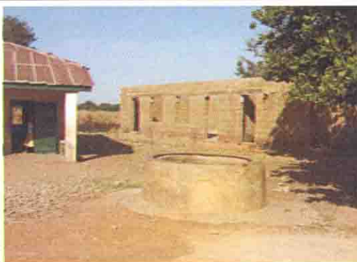
LGAにより建設中の校舎
