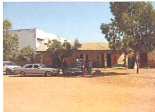
既存校舎の全景 (一部幼稚園で使用)
