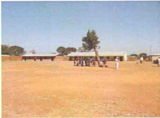
既存校舎の全景
