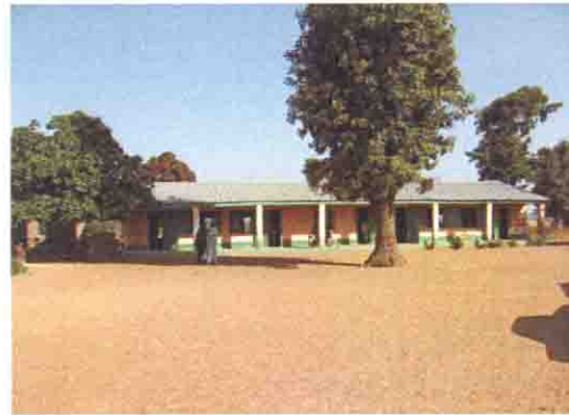
既存校舎の全景
