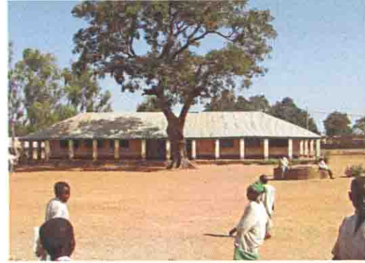
既存校舎の全景
