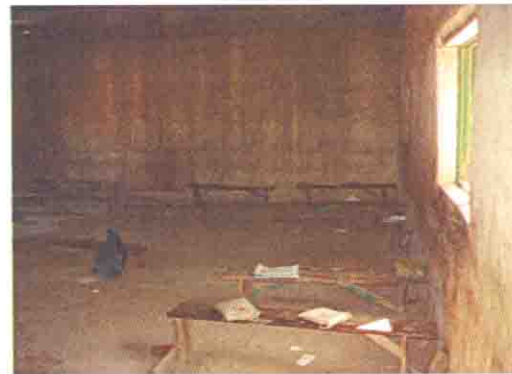
教室内部 (床が土間状になっている)
