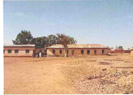
既存校舎の全景
