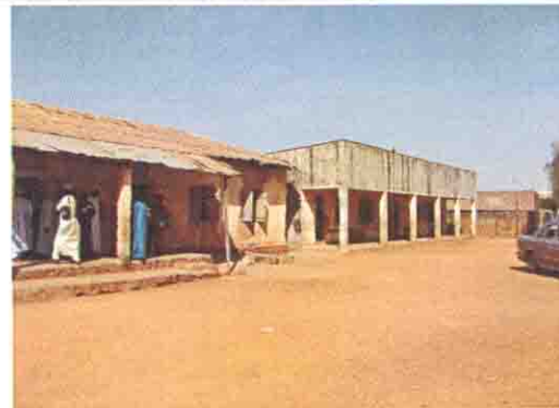
既存校舎の全景
