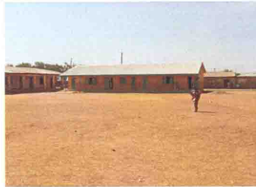
既存校舎の全景 (2002年新築)
