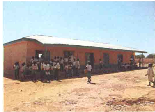
既存校舎の全景
