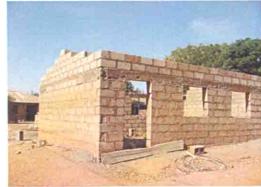
コミュニティにより建設中の校舎
