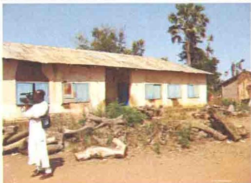
既存校舎の全景
