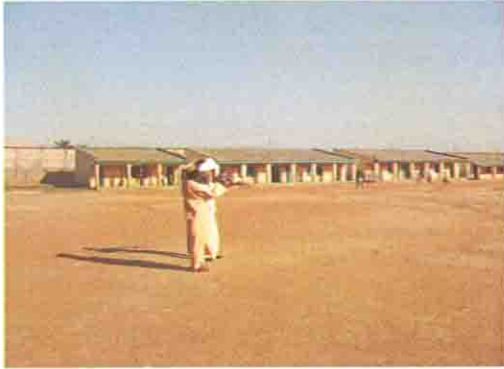
既存校舎の全景 (Kaduna市街地内の学校)
