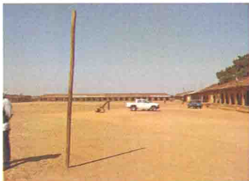
既存校舎の全景
