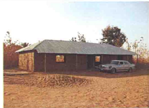
コミュニティにより建設中の校舎
