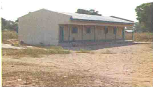
既存校舎の全景
