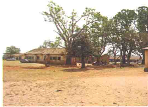
既存校舎の全景
