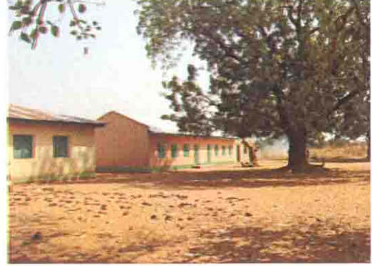
既存校舎の全景
