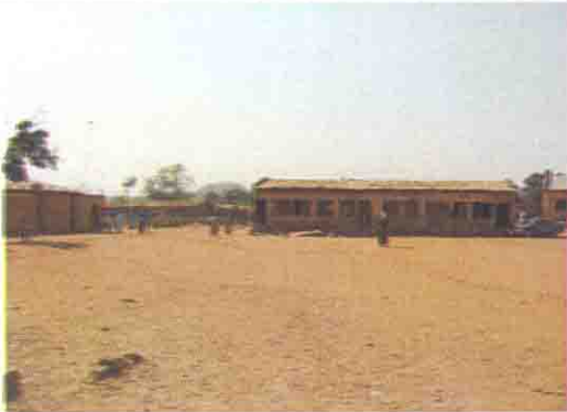
既存校舎の全景
