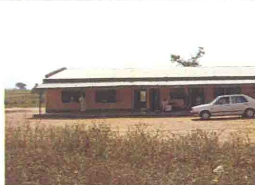
既存校舎の全景
