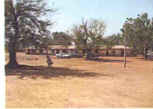
既存校舎の全景
