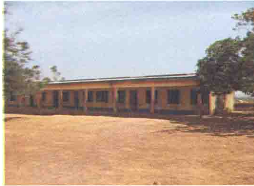
既存校舎の全景
