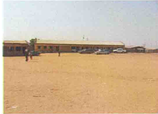
既存校舎の全景
