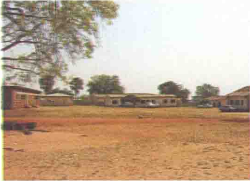
既存校舎の全景
