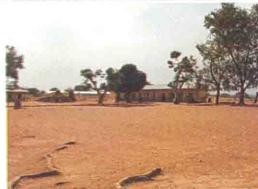
既存校舎の全景
