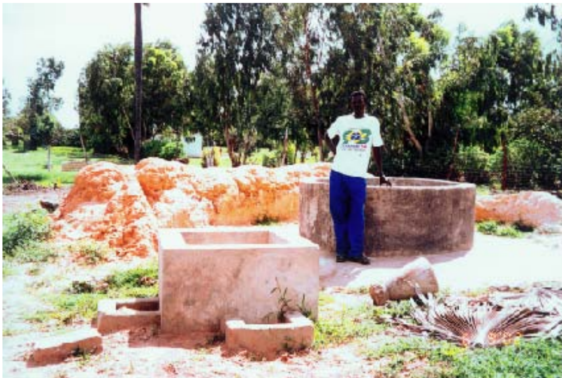
井戸。ポンプは盗まれないよう倉庫に保管しており、毎日出してきてとり付ける。この井戸のすぐ近くにカリタス（NGO）でつくった井戸がある。（テロワール フィムラ）
