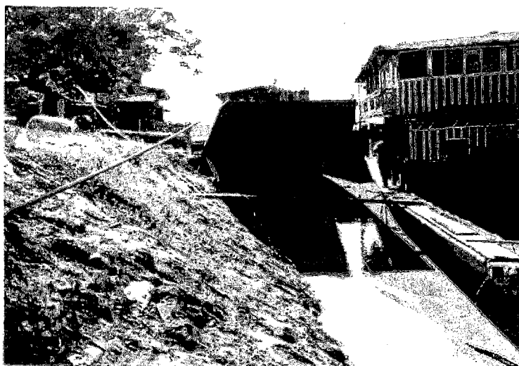
下流側（捨て石をセメントで固定）
