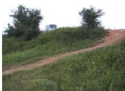
植生で保護された盛土のり面
