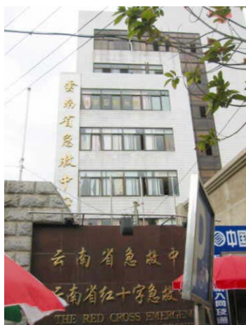
昆明救急医療センター外観
