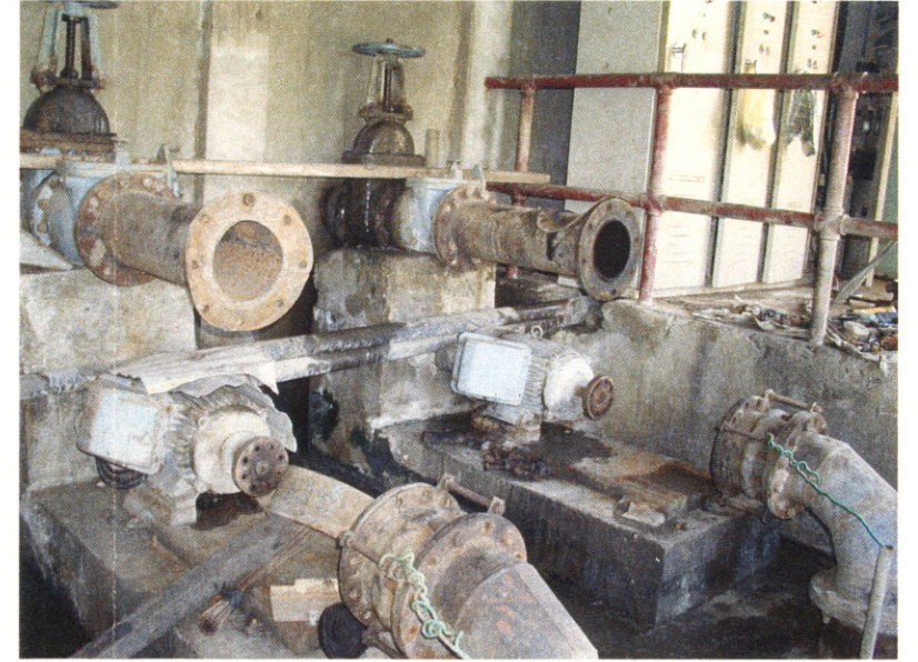
ポンプ場内の様子(矢印→の向き) ポンプは修理のため取り外されている
