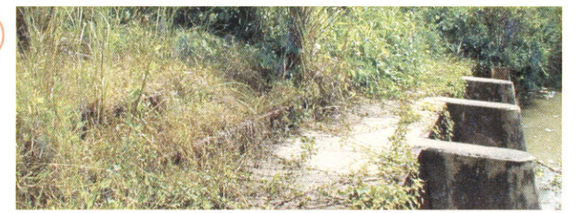
⑫ 角落し 土砂流入防止のため横置きされている
