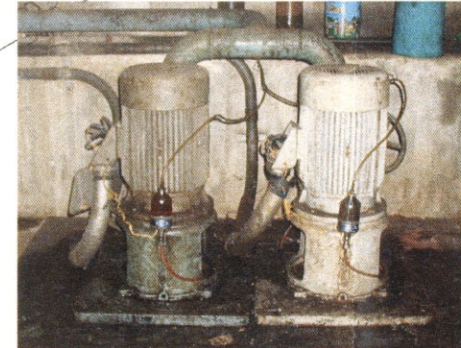
⑤ 場内排水ポンプ 軸受が磨耗し振動
