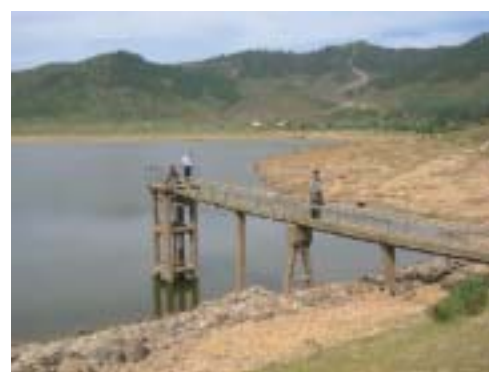
Ho Thanh 溜池と取水設備
