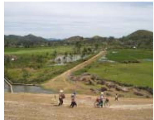
No. 2 水路始点を溜池堤防から望む
