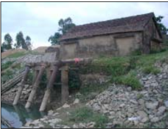
・現 Nam Trung ポンプ場（改修予定）
