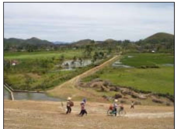
・Ho Thanh ため池水路：上流側
