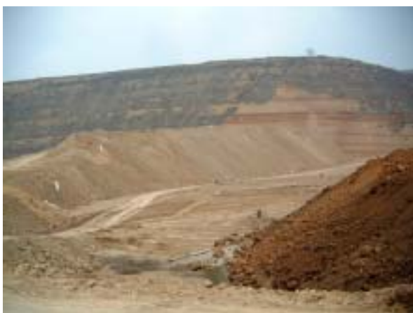
最終処分場覆土保管状況
