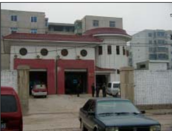
未央区小規模ごみ圧縮ステーション
