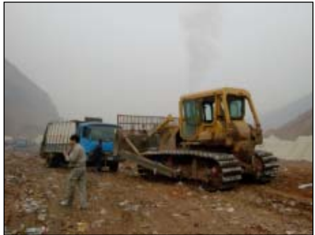
最終処分場内ブルドーザー(2)
