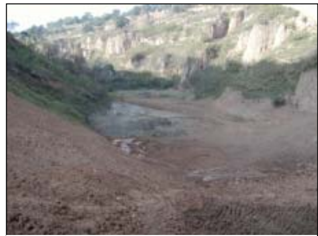
浸出水処理施設建設予定地
