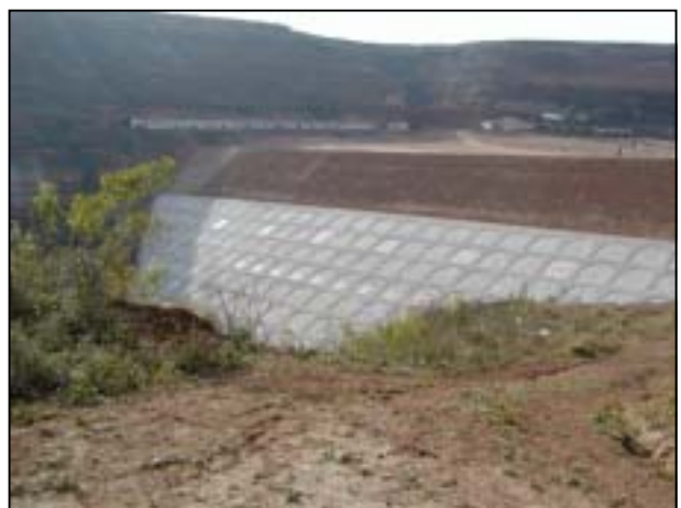
最終処分場上流部貯留構造物
