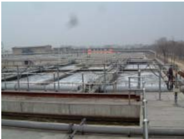
中継輸送基地排水放流先第1污水处理場
