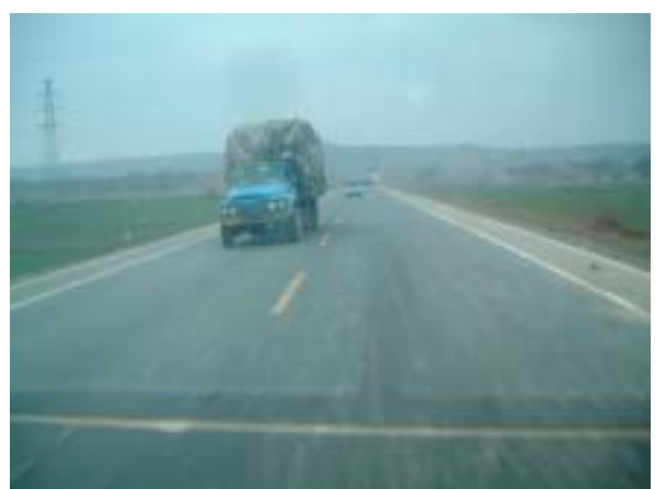
最終処分場への新設アクセス道路
