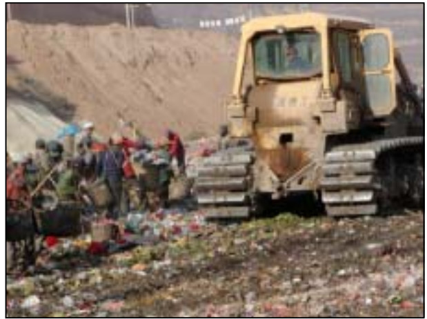
スカベンジャーの脇で作業を行うブルドーザー
