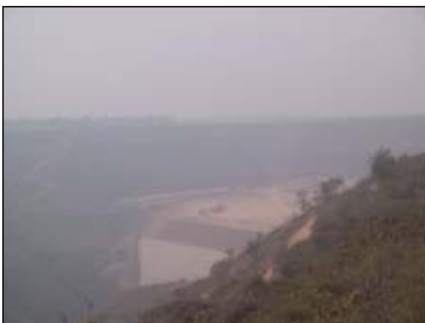
最終処分場第1期地区遠景(上流部より)
