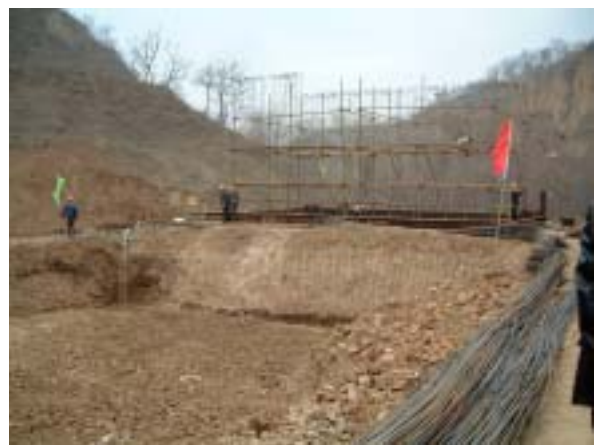
最終処分場浸出水処理施設建設状況
