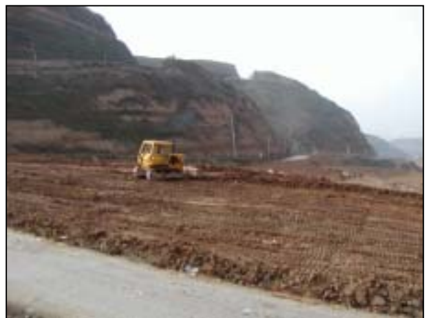
ブルドーザーによる覆土作業風景
