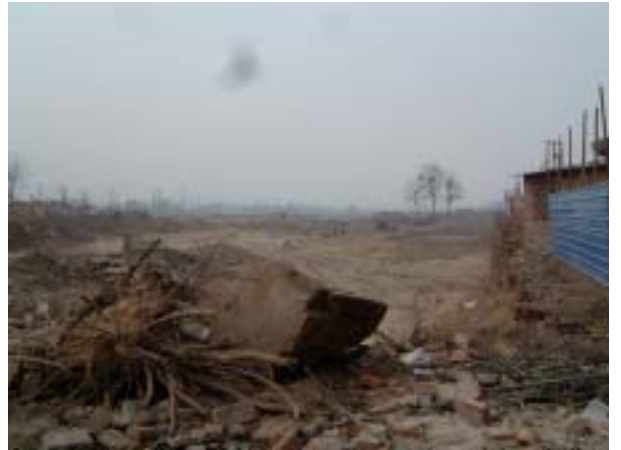
中継輸送基地南側高速道路建設工事状況
