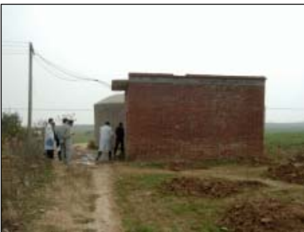
地下水採取状況(1) (井戸小屋)
