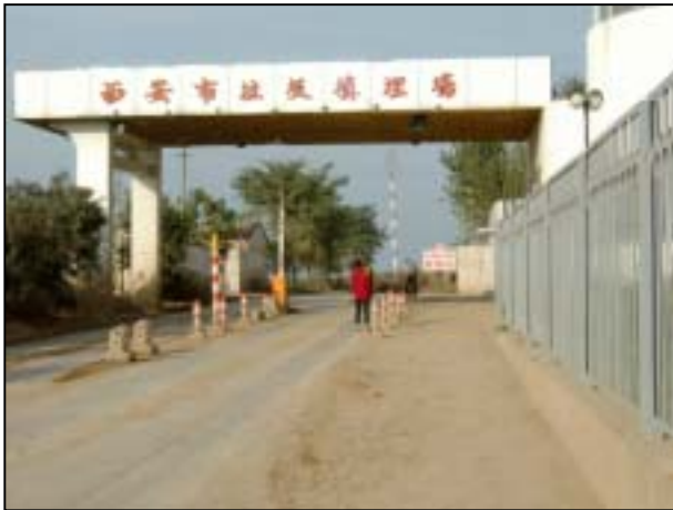
最終処分場入り口及びトラックスケール (調整中)
