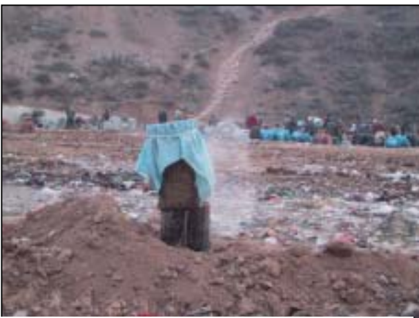
ガス抜き設備
