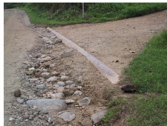
取付け道路横断管状況 (排水管露出)
