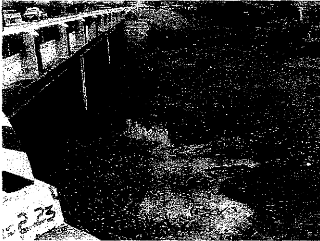
Canal principal aguas arriba del puente El Junquillal n = 0.027
