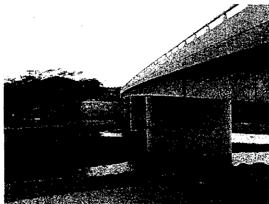
Foto 5.5.4 Puente Río Negro
