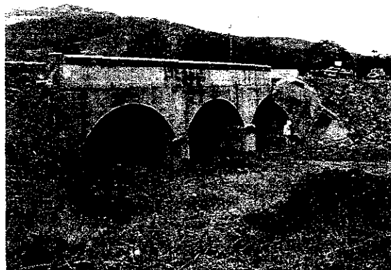
Foto 5.2.3 Puente de El Guayacán (Aguas abajo)
