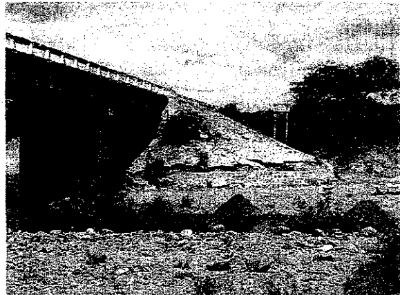
Photo 5.1.6 Río Tapacalí Bridge
