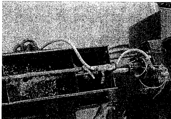
パイプ押し機を上から見た写真
