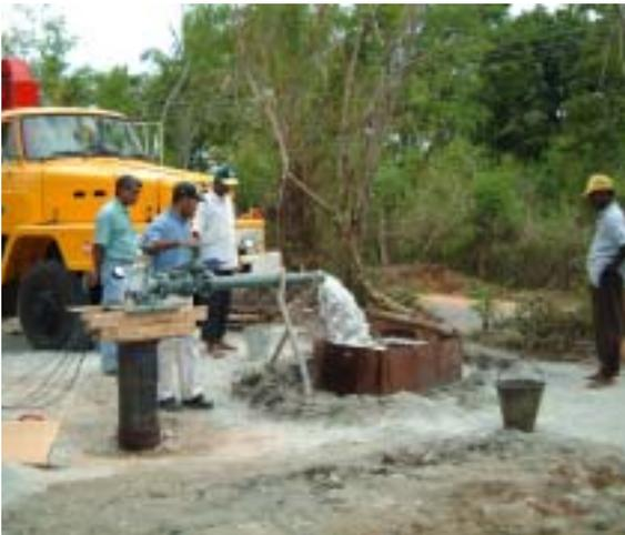
供与機材の水中ポンプを使って揚水試験を実施する WRB の技術者達
