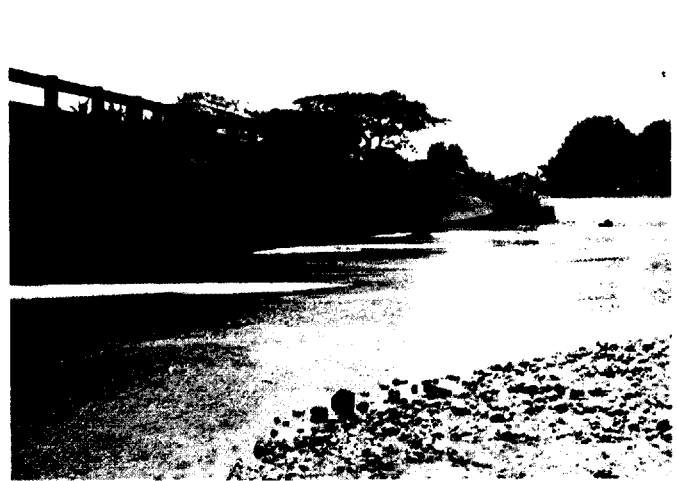
主要国道の橋梁
