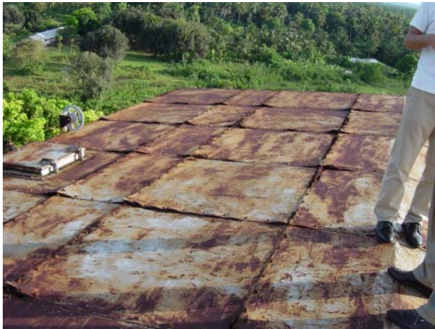
さびの激しい鋼製タンクの天井。
