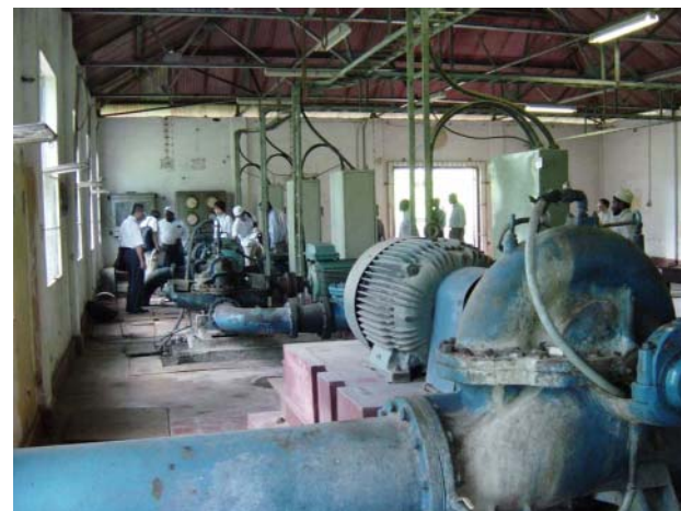
Saateni 配水場内のポンプ場 ( 540\text{m}^3/\text{h} \times 52\text{m} \times 2 台、 225\text{m}^3/\text{h} \times 63\text{m} \times 2 台)
