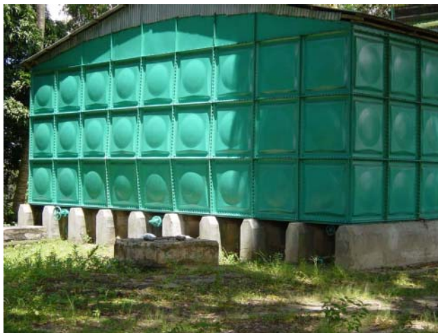
Welzo 配水場内の鋼製地上タンク（420m 3 ）である。漏水が激しかったために、2001年にザンジバル政府自己資金で修理された。
