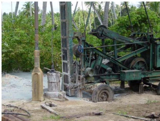
FINNIDA から供与された井戸掘削機を使用して、DWD が掘削中の井戸ポンプ (U-051)。
