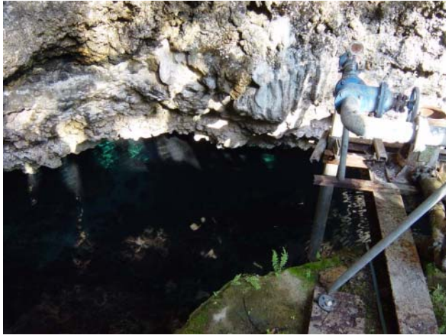
Dinami Cave (鍾乳洞) 水源である。ザンジバル都市部から南東 14km に位置する。水量は豊富である。水中ポンプ容量：80m 3 /hr。
