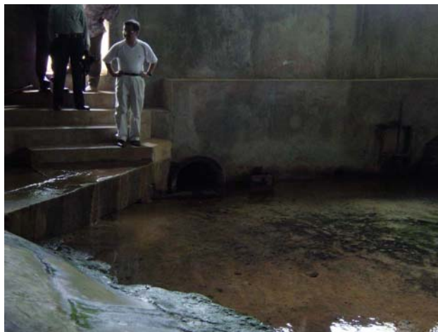
Mtoni Spring の取水 (雨期: 7200\text{m}^3/\text{日} 、乾期: 3400\text{m}^3/\text{日} )
