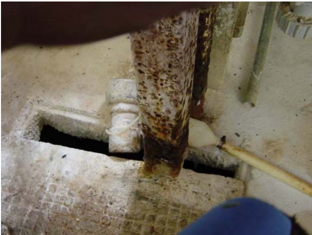
Saateni 配水場内の滅菌装置。（下部の水槽に細いビニールパイプから落下する。）
