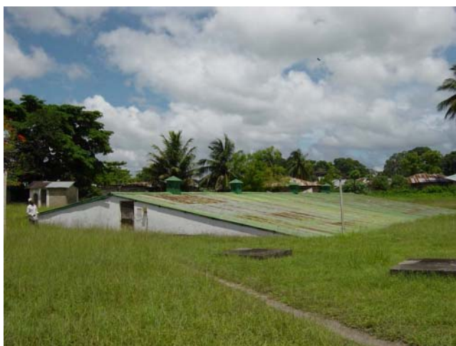
Saateni 配水場内の地下式配水池（コンクリート造、 1000\text{m}^3 ）。
