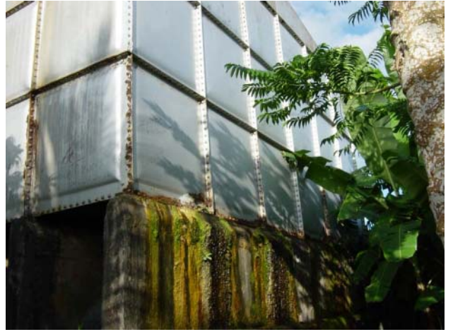
Dinami Cave から約 1km 離れた Haitajwa Hill に建設された鋼製タンク、老朽化が激しく漏水している。タンクの修復はザンジバル政府により既に承認され、近々に材料も入る予定である。
