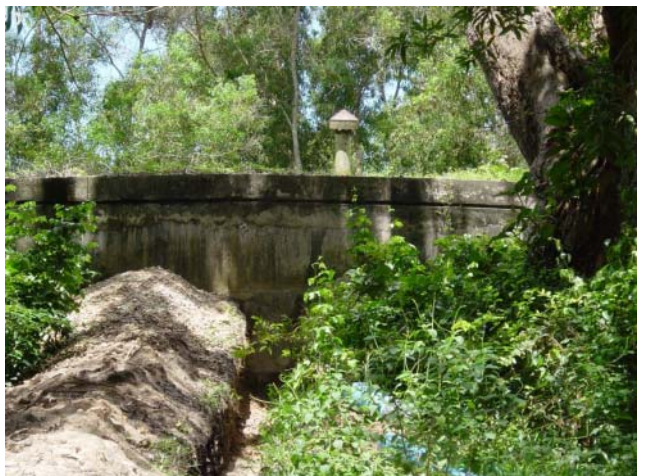
Welzo 配水場内の地下水配水池（コンクリート造、2250m 3 ）である。現在、DWDが配水管接続工事を行っている。
