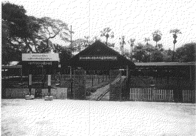
CFDTC サブセンター 建設予定地 (マンダレー管区、 パティンジタウンシップ、 森林局事務所敷地内)
