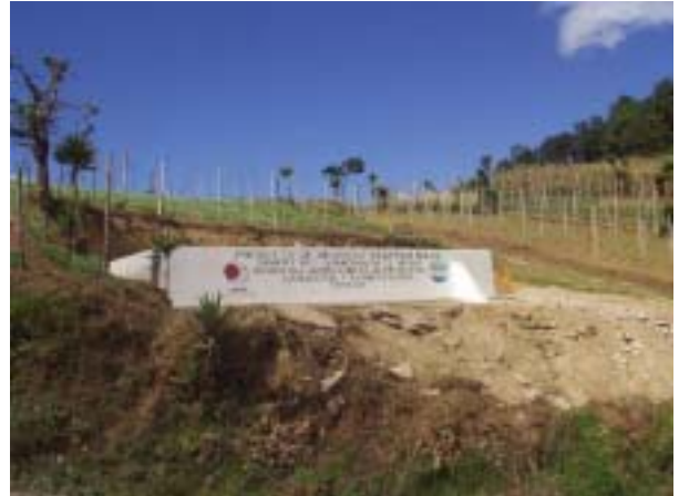
ミニ灌漑計画：貯水タンク建設
