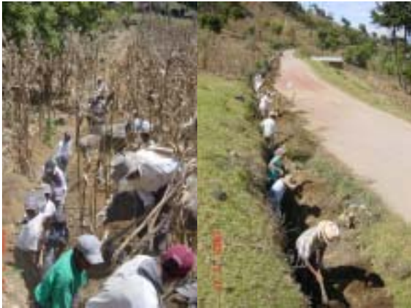
ミニ灌漑計画：パイプライン埋設
