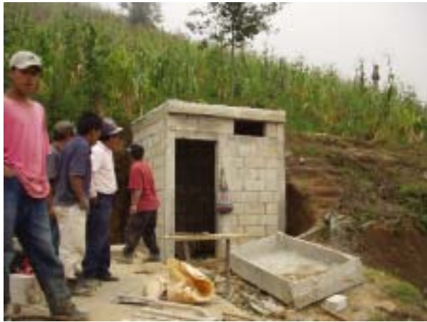
飲料水水質改善計画：建家建設
