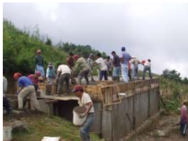
飲料水施設改修計画：貯水タンク建設
