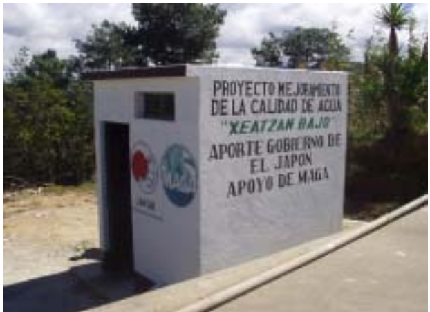
飲料水水質改善計画：塩素滅菌装置建家
