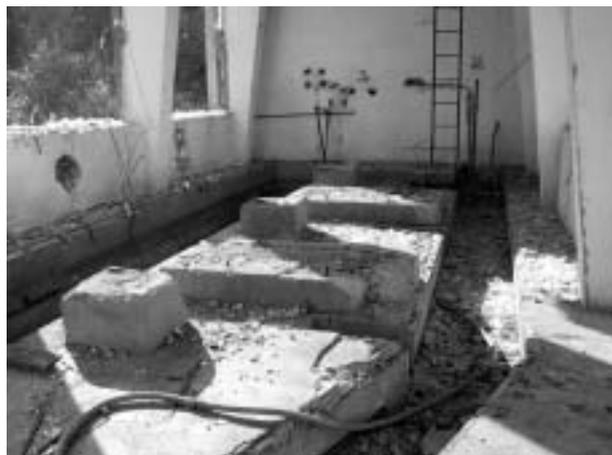
窓も壊され、ポンプも撤去された灌漑ポンプ場
