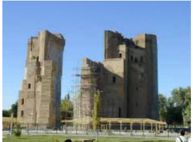
シャフリサーブス 遺跡修復中
