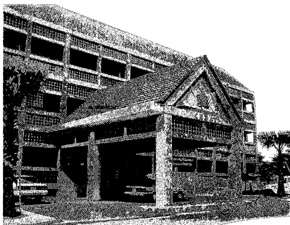
1. 国立結核対策センター全景
